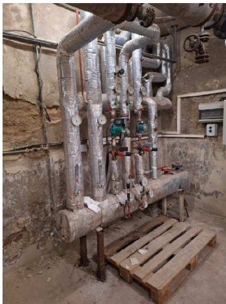
Horkovod – rozdělovač – 1PP skleníku
